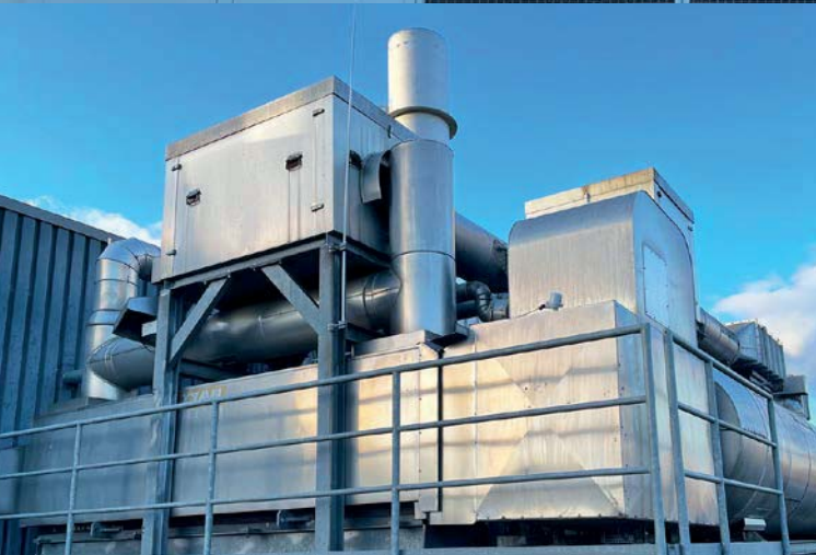
Abb. oben: Installierte Kälteanlage für Kühlprozesse in der Produktion (2021); Abb. links: Abluftreinigungsanlage mit Wärmerückgewinnung
